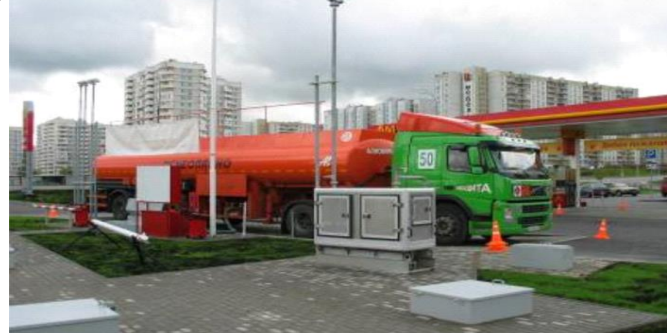
Установки сжижения ЛУВ для АЗС ( «Промприбор») – адсорбция на угле
