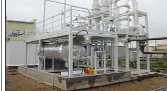
Установки сжижения ЛУВ для нефтебаз ( «Газспецтехника») методом захолаживания
