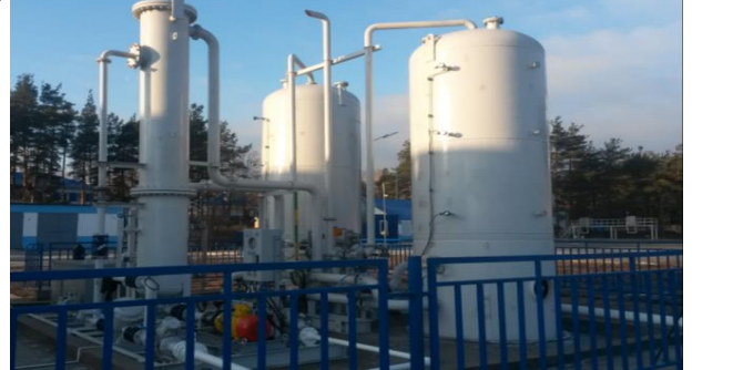
Установки сжижения ЛУВ для нефтебаз ( «Промприбор») – адсорбция на угле
