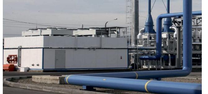
Установки сжижения ЛУВ для нефтебаз ( «Газспецтехника») методом захолаживания
