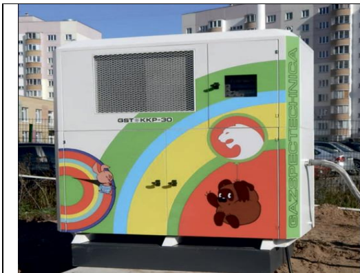
Установки сжижения ЛУВ для АЗС ( «Газспецтехника») методом захолаживания
